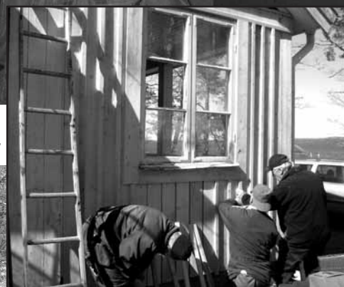
Fönster och vindskydd på plats
